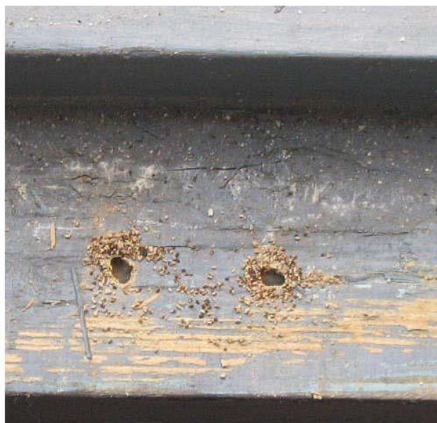
Termitas aéreas comiendo una madera (izquierda) y orificio de salida de sus excrementos (derecha)
