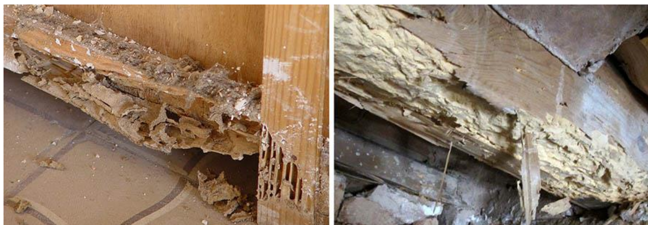
Fotografía izquierda: Galerías y "barro" seco de termitas subterráneas, Fotografía derecha: Galerías de carcoma grande
