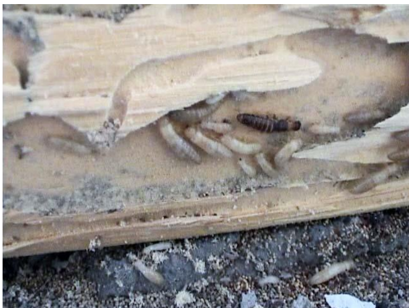
Termitas aéreas comiendo una madera (izquierda) y orificio de salida de sus excrementos (derecha)
