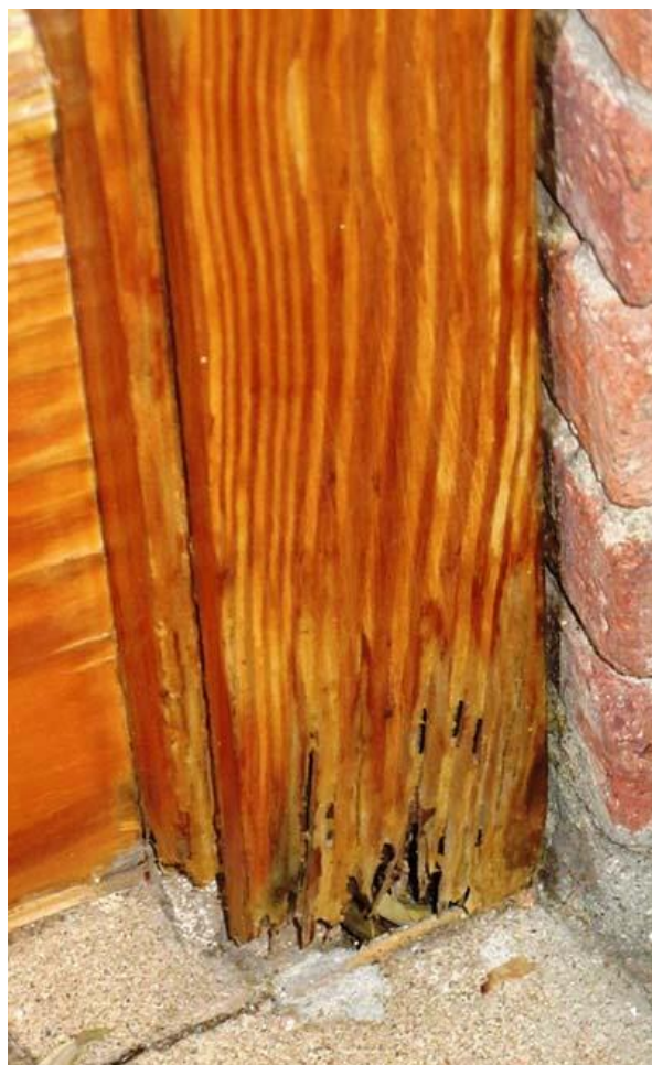
Foto izquierda: Base de un marco atacado por termitas subterráneas. Foto derecha: Canales termíticos escondidos en un falso techo y aprovechando la humedad de los bajantes
