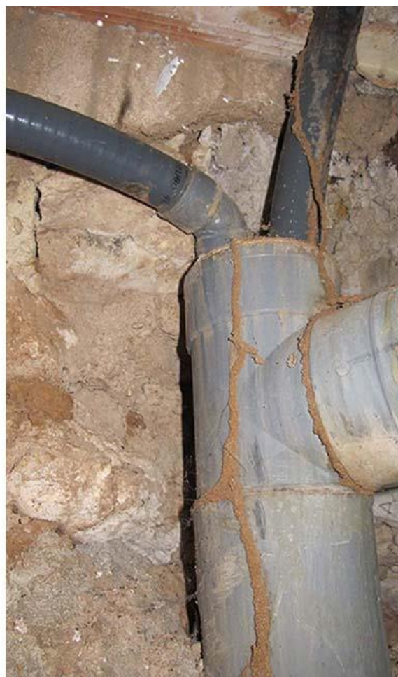
Foto izquierda: Base de un marco atacado por termitas subterráneas. Foto derecha: Canales termíticos escondidos en un falso techo y aprovechando la humedad de los bajantes
